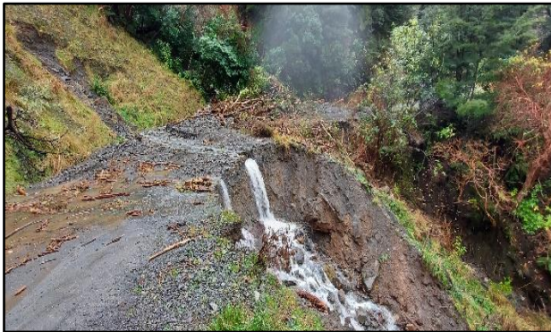
Washout on Puhi Puhi Rd – Culvert #70
